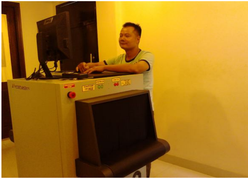
Lắp đặt cân chỉnh thiết bị tại đại sứ quán Coet
