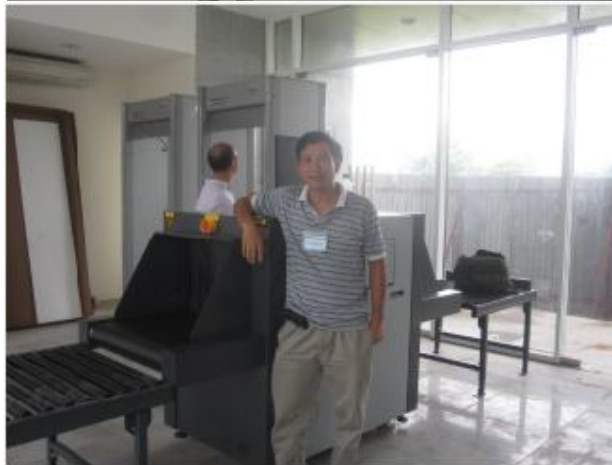
Cung cấp lắp đặt, cân chỉnh bàn giao cho người sử dụng
