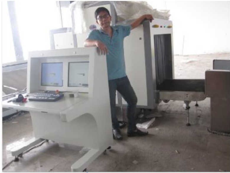
Lắp đặt và chạy thử
